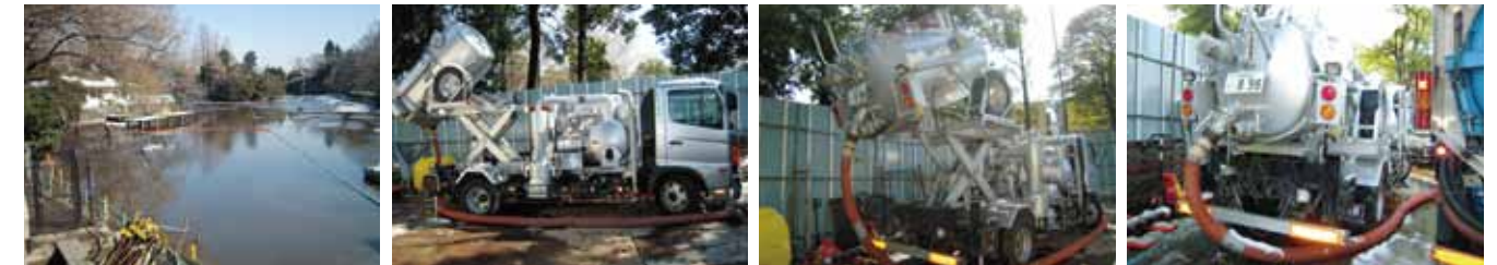
作業例:東京都富士見池の浚渫工事(株式会社 ユーキ建工様)
