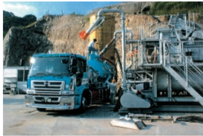
流動化処理土製造プラントで製品を作り車輻に投入します。
