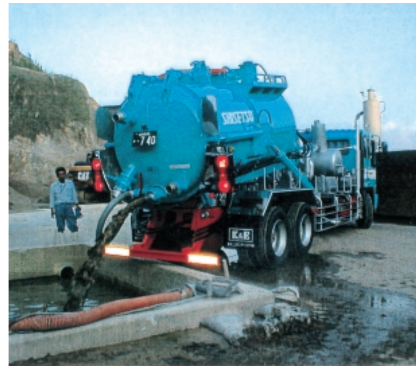
現場にて打ち込み。打ち込みは、ブロワーによる圧送で行います。(打ち込みにホースを使用すれば狭い場所での作業が容易に行えます。)
