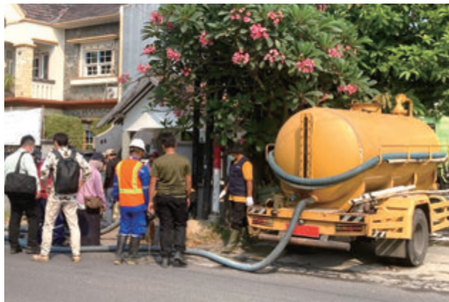
下水道管きよ清掃作業の視察
