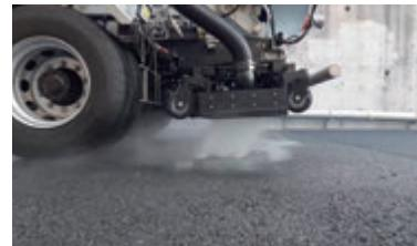
高圧水の噴射によって路面を清掃します。(実際の清掃時は、アタッチメントを接地させるため、粉じんを周囲に飛散させない仕組みです。)
