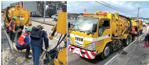
災害現場で作業する様子
