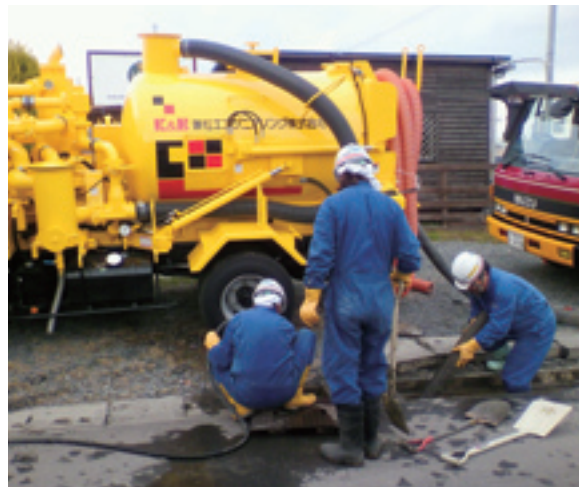
新型SME-04BVPによる側溝汚泥吸引風景
