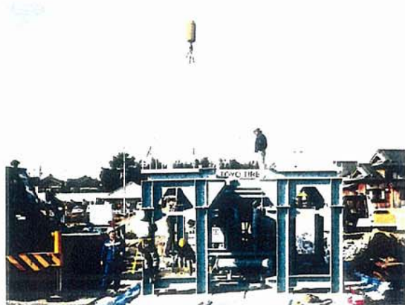
混練機組立中
