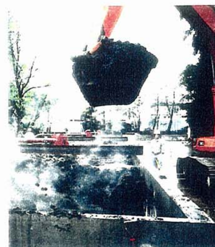
固化後ダンプ搬出
