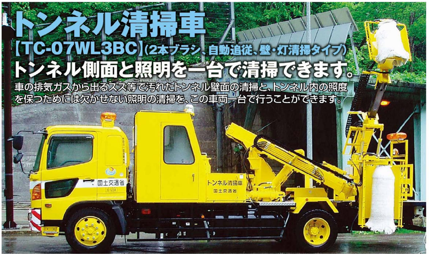
照明の清掃作業
