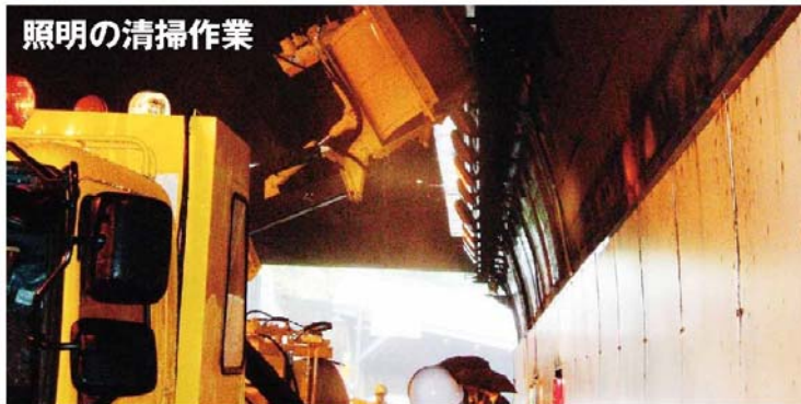
壁面の清掃作業
