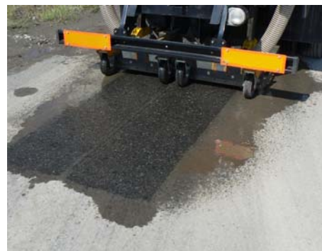
乾いた路面の清掃の様子
